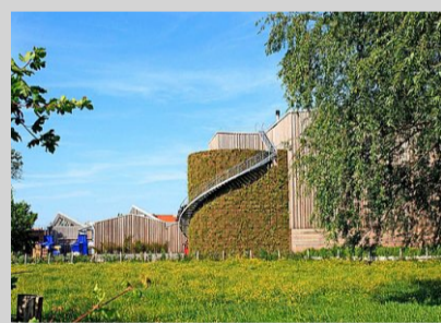
Pocheco et sa cuve poilue pour réserve incendie. WIKIPEDIA/L. MAYEUX
